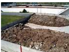
Stockage des boues
