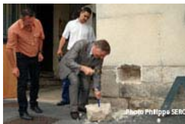
Monsieur le Maire en pleine action de démolition
